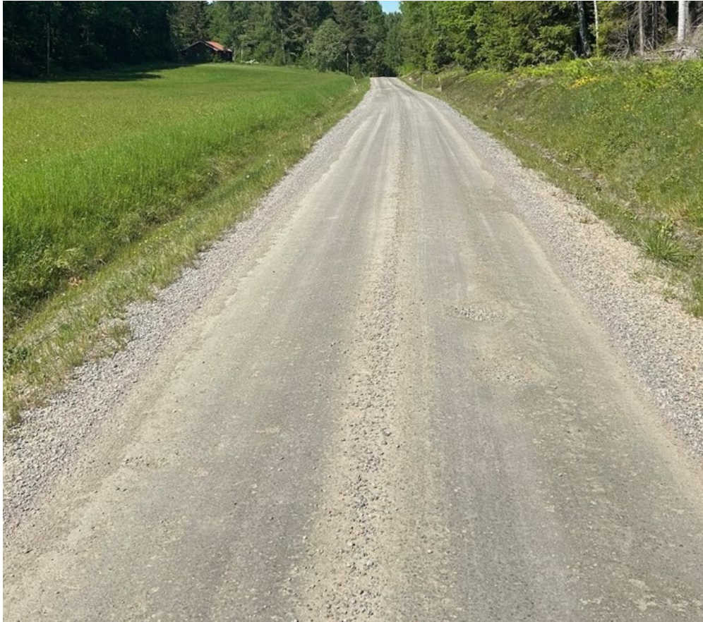
Gruslitrager av kvartsdiorit utan tillsatt filler
