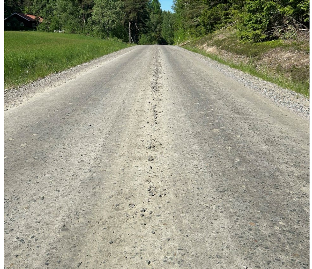
Gruslitrager av kvartsdiorit med 17 vikt-% tillsatt filler
